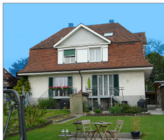
Beispiel einer realisierten, typähnlichen Lösung am Lerchenbühlweg 35/37
